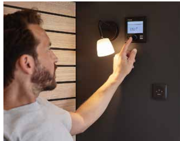
LICHT- UND HEIZUNGSSTEUERUNG IM SCHLAFBEREICH
